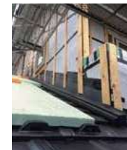
透湿防水シートの継ぎ目 (エースクロス011黒使用)
