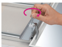
③ハンガーボルトを数回回し締めつけ固定
