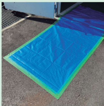
養生シートの仮固定
