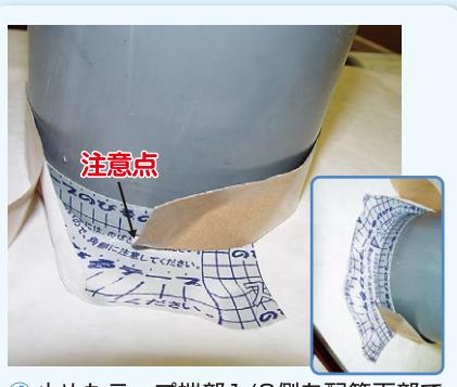
④止めたテープ端部1/3側を配管下部で丁寧に重ね巻付け合わせて貼る。
