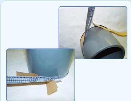
①パイプの下側より、巻付けるように1/3側の剥離紙を剥がしながら少し引張りながら貼る。
