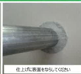
配管周辺もすき間なく充填してください
