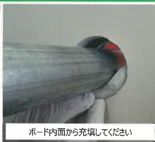
配管周辺もすき間なく充填してください
