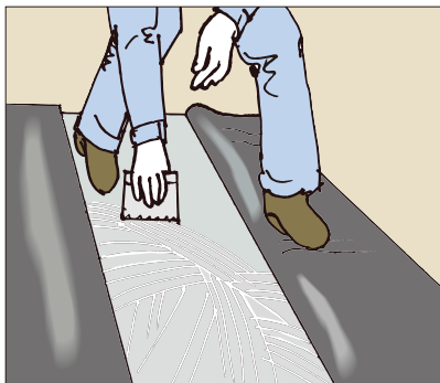
●塩ビ床シート・PVCタイル・コンポジションタイルの施工に
