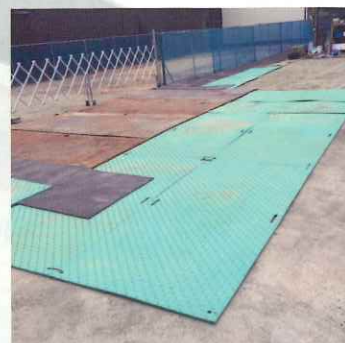
建設現場入口
