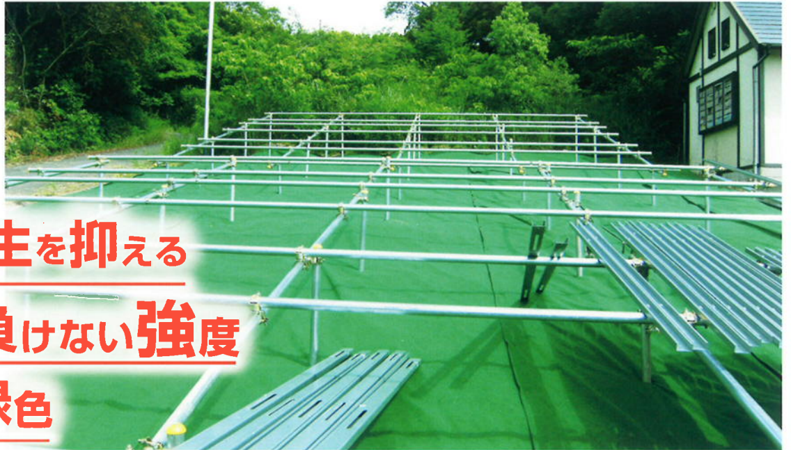
施工例：電力施設（和歌山県紀ノ川市）
