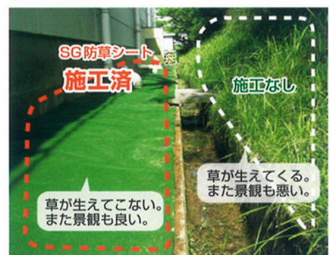
施工例：社屋内側溝（新江州パッケージ(株)）
