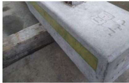
PCコンクリート養生
