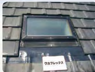
異形個所の補修事例
