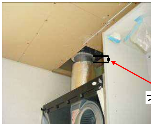
②レンジフード接続
