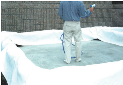
夏場は施工後、散水する
