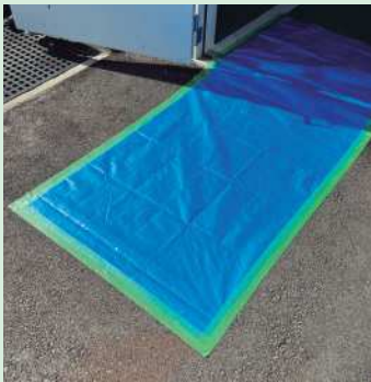
養生シートの仮固定
