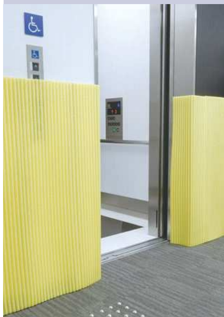
エレベーターまわりの養生に
