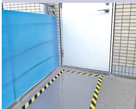
通路の養生に
