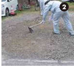
地面が平らになるよう敷き均す
