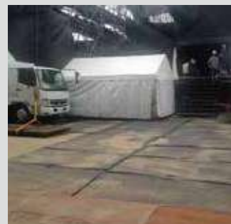
イベントステージ設置工事
