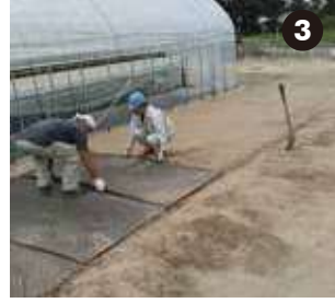
ボードを敷設する
