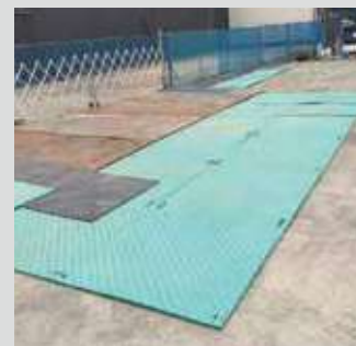
建設現場入口
