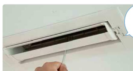
風量測定部材で正確な風量を測定でき、
