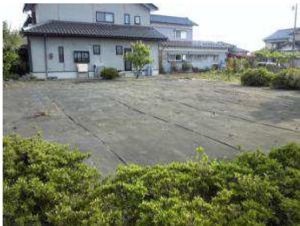
施工現場全景
