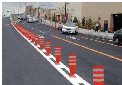
駐車場出入口部
