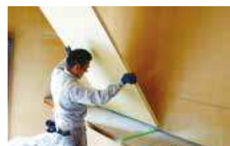
既存壁の内側からボード取付け
