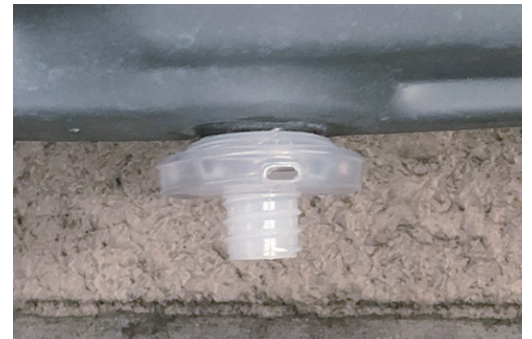
エアコン室外機の底面にアジャスターを取り付け
