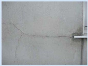
1. 補修箇所の確認
