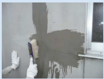
3. 補修部の周辺に十分水湿しを行う。
