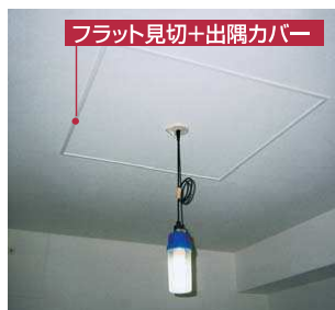
●天井部分のリフォーム例
